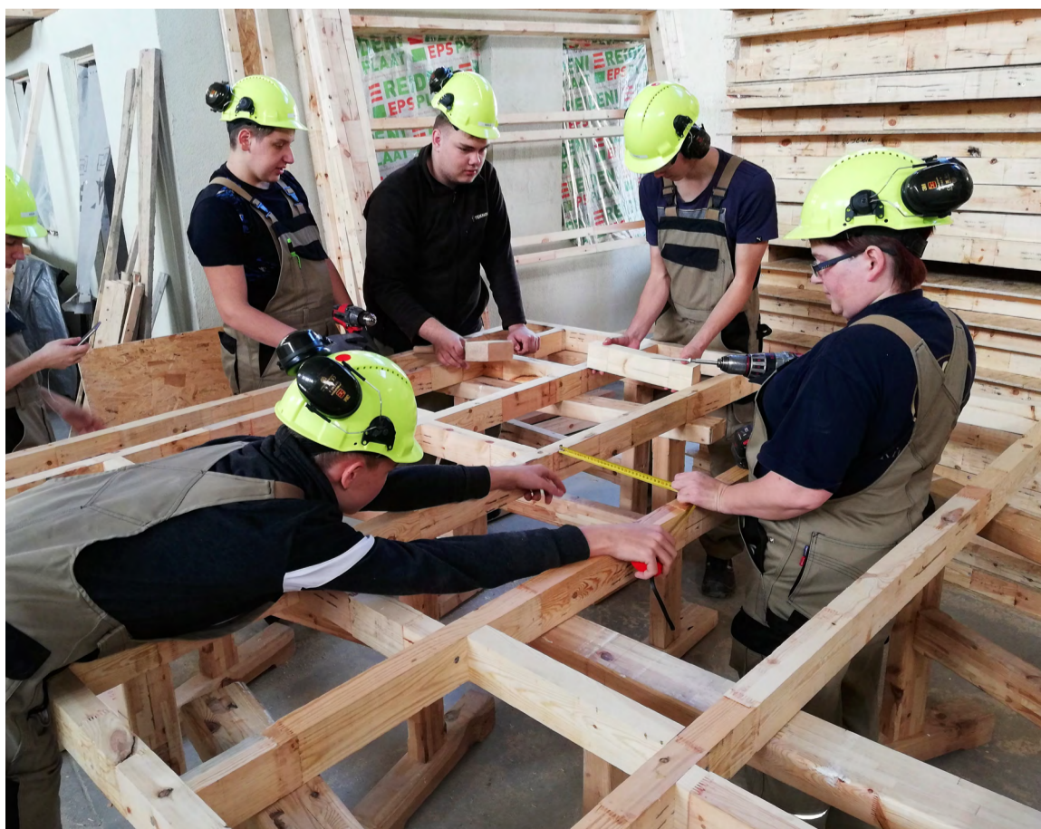
Rakvere Ametikooli esimese kursuse puitkonstruktsioonide ehituse eriala õpilased jõuluküla maju ehitamas.
